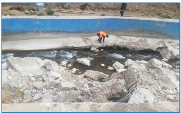
IMAGEN 04: SE MUESTRA EL ESTADO ACTUAL DEL CAUCE DEL RIO PALLCA SE REQUIERE DE DEMOLICION DE MURO DE CONCRETO Y EL MEJORAMIENTO MEDIANTE MUROS DE PROTECCION ANTE INUNDACIONES
