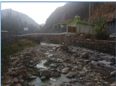
IMAGEN 03: SE MUESTRA EL ESTADO ACTUAL DE LA MARGEN IZQUIERDA DEL RIO PALLCA REQUIERE DE LIMPIEZA Y DESCOLAMTACION Y CONSTRUCCION DE MURO DE CONCRETO
